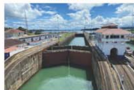
第二閘門和第三閘門
