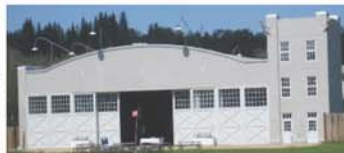
布拉奇福德機場航空機庫
