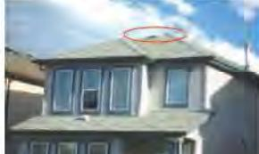
圖三：坐東南向西北，屋頂前端加了兩個散熱透氣蓋。
